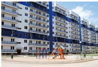
Объект: Алматинская область, Карасайский район, с. Иргели, ж.м. Асыл-Арман, Общая площадь: 37 247,9 м 2 Количество квартир: 708 Дата ввода в эксплуатацию: 02.03.2015
