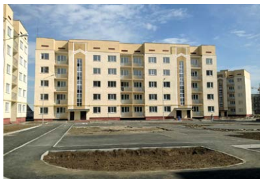
Объект: г. Алматы, мкр-н Жас Канат Общая площадь: 54 656,5 м 2 Количество квартир: 954 Дата ввода в эксплуатацию: 31.08.2017 и 05.09.2017
