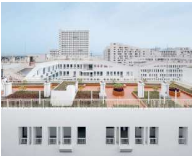
Сгруппированные выводы инженерных коммуникаций на эксплуатируемой крыше Longnan Garden Social Housing Estate (Сюйхуэй, Китай)
